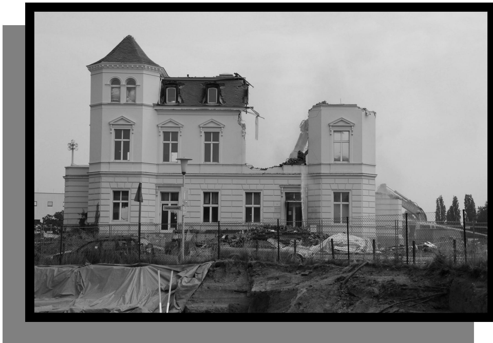
Abriss Villa Dahm/Haus der Parlamentarischen Gesellschaft wg. Errichtung des WCCB 2006
